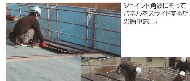
▲パネルの設置▶
