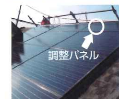
◀調整パネルの設置
