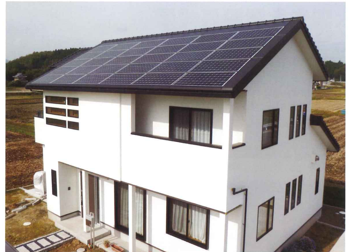
新築 6.00kW 茨城県北茨城市
