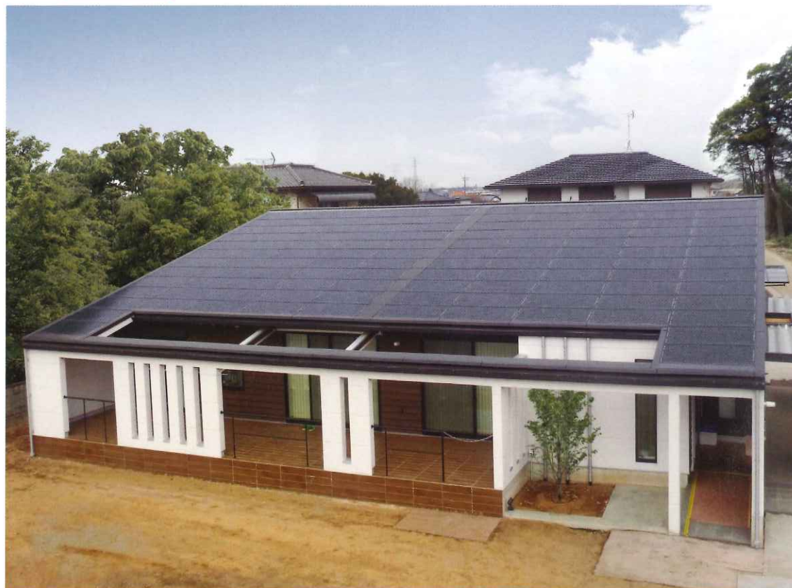
新築 22.23kW 茨城県坂東市
